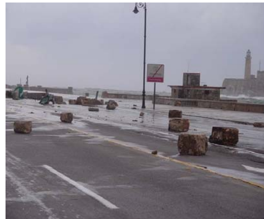
D-Huracanolitos antrópicos representados por fragmentos del muro arrancados por las olas del malecón habanero.
