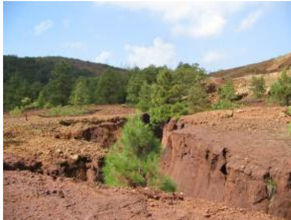
Figura 6. Escarpe principal de un deslizamiento rotacional en suelos lateríticos en el territorio de Moa (Almaguer, 2005).
