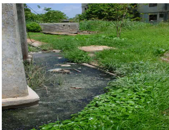
Figura 1.- Vertido de aguas albañales en el poblado de Dagame nuevo
